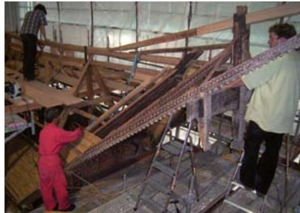
Abb. 10: Restauratoren und Dachdecker bei der Arbeit am Dachstuhl; die hellen Hölzer wurden zur Stabilisierung eingebracht.
