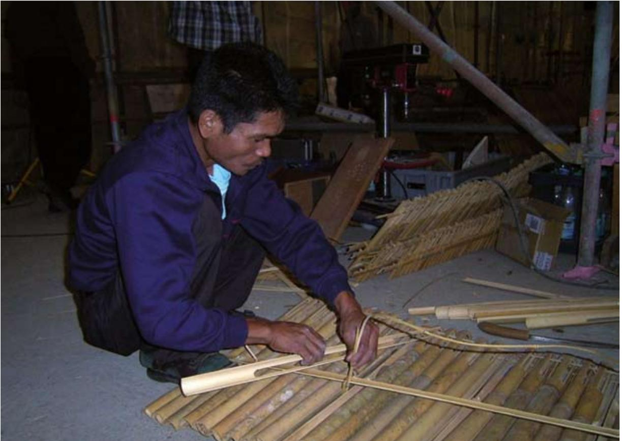
Abb. 11: Trägerschicht für die Schindeln – mit Rotang befestigte Bambusstangen.
