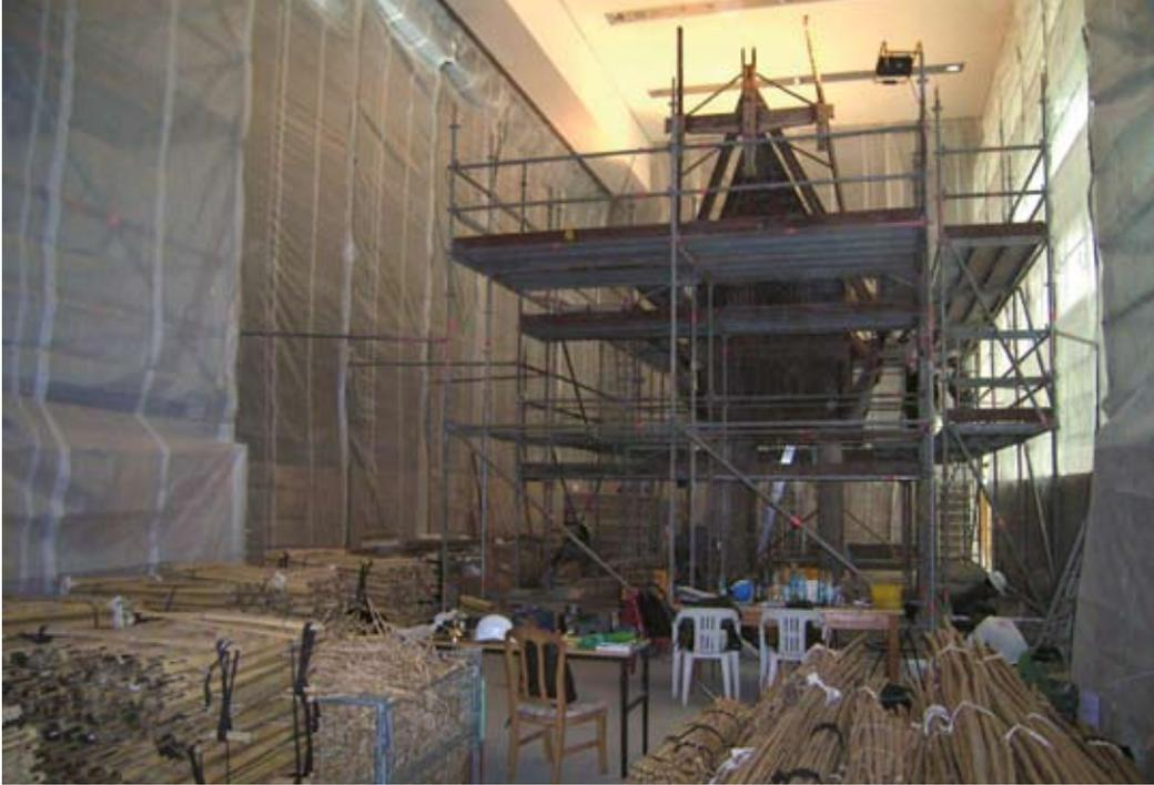
Abb. 8: Der Reisspeicher hinter neuem Gerüst; im Vordergrund Mengen aufgestapelter Bambusschindeln.
