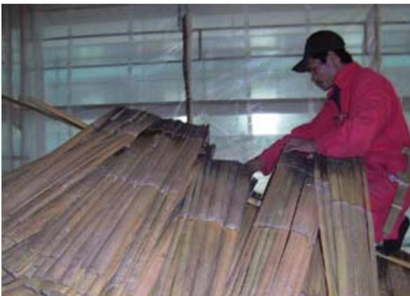
Abb. 15 a, b: Die Schindeln werden in Lagen aufgeschichtet.
