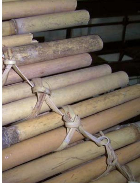
Abb. 14 a, b: Kunstvoller Rotangverschnürungen halten das gesamte Bambusmaterial auf dem Dachstuhl fest und zusammen.
